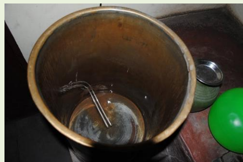
De warmwaterketel van binnen. Onderin het warmte-element. Als er niet voldoende water in zit, dan kookt de ketel droog. Erg brandgevaarlijk.
